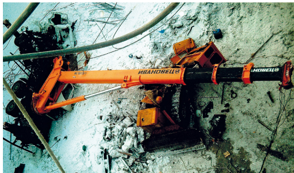
Рис. 48. Опрокидывание крана КС-55735-1
