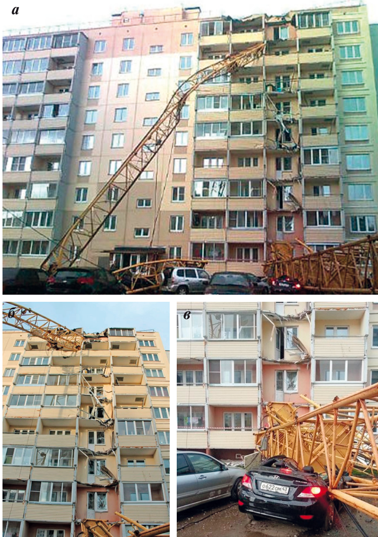
Рис. 50. Падение башенного крана КБ-408 на жилой дом:
